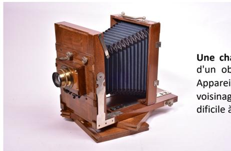
Une chambre noire 13x18 à pied munie d'un objectif anastigmat Demaria frères. Appareil stable, servant à bord ou dans le voisinage du navire, mais encombrant, difficile à manier par les gros froids.
